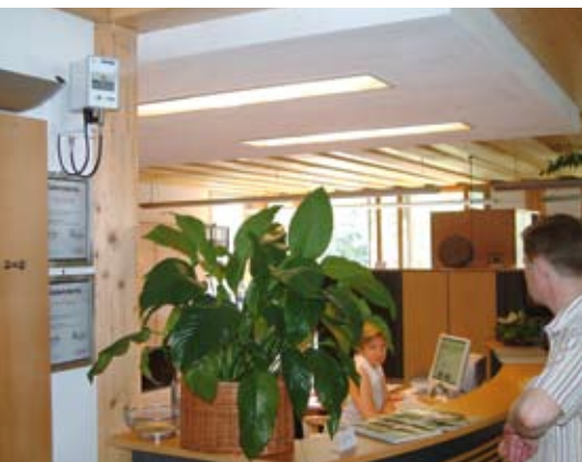
Ein Komfort-Befeuchter je Büroeinheit verbessert bei der Österreichischen Bundesforste AG das Raumklima
