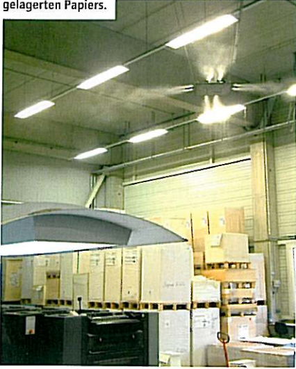
Das Draabe Hochdrucksystem TurboFog 32 vernebelt über acht Dralldüsen bis zu 32 l Reinwasser/Stunde.
